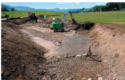
Bau der Offenlegung Sägenbach
